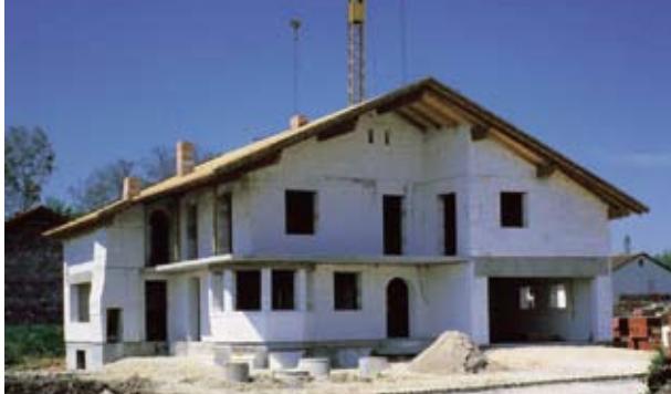
Construction en béton cellulaire
